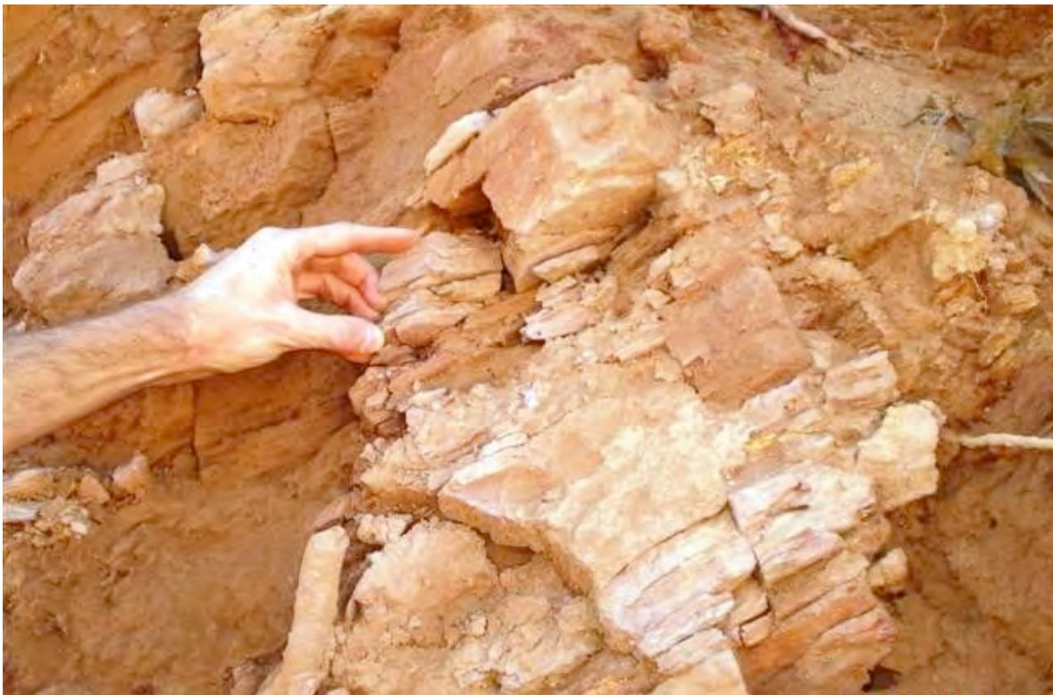
Figura 4 – Detalhe da rocha alterada na fundação
